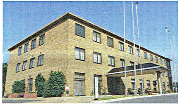
1998年に移転開設された青葉台病院(48床)。循環器、呼吸器、消化器疾患や脳血管障害、悪性腫瘍など幅広い病気の患者を受け入れている。
